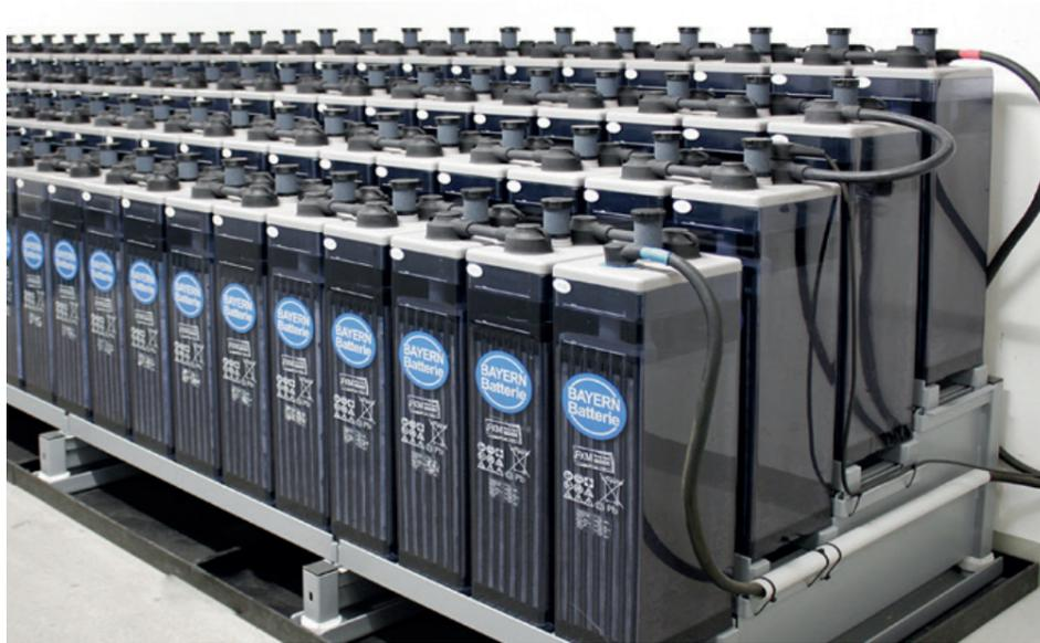
Geschlossene Bleibatterien sind Batterien mit freiem flüssigem Elektrolyten, welche als wartungsarm gelten (Antimongehalt unter 3 %).
